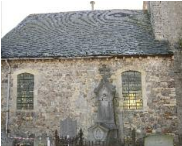
Het oudste deel van de kerk is te herkennen aan het ruwere metselwerk en de minder goed afgewerkte stenen.
