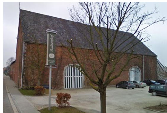
Figuur 7 De indrukwekkende dwarsschuur van het Aulnehof in Walshoutem heeft twee dorsvloeren. Haar naam verwijst naar de abdij van Aulne bij Charleroi, die de abdijhoeve op het einde van de zeventiende eeuw bezat, naast heel wat grond en andere gebouwen.
